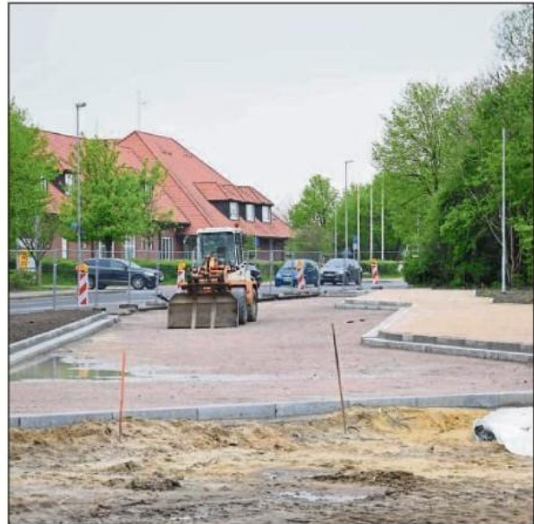
Die Pflasterarbeiten an der Bushaltestelle am Bildungszentrum sind vorverlegt worden.
