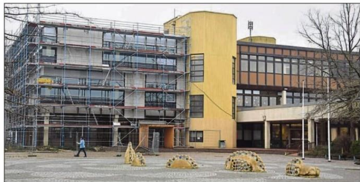
Fassadensanierung: Ein Gebäudekomplex des Bildungszentrums ist komplett eingerüstet.
