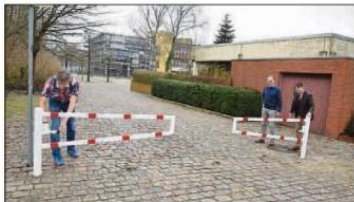
Sorgt für mehr Sicherheit: Die neue Schranke an der Zufahrt zum Pausenhof.
