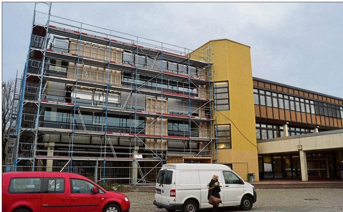
Links neu, rechts alt: Die ums Gymnasium herumwandernde Fassadensanierung ist auf der Vorderseite angelangt. Noch das gesamte kommende Jahr muss der Unterricht teilweise ausgelagert werden. Foto: Thaden
