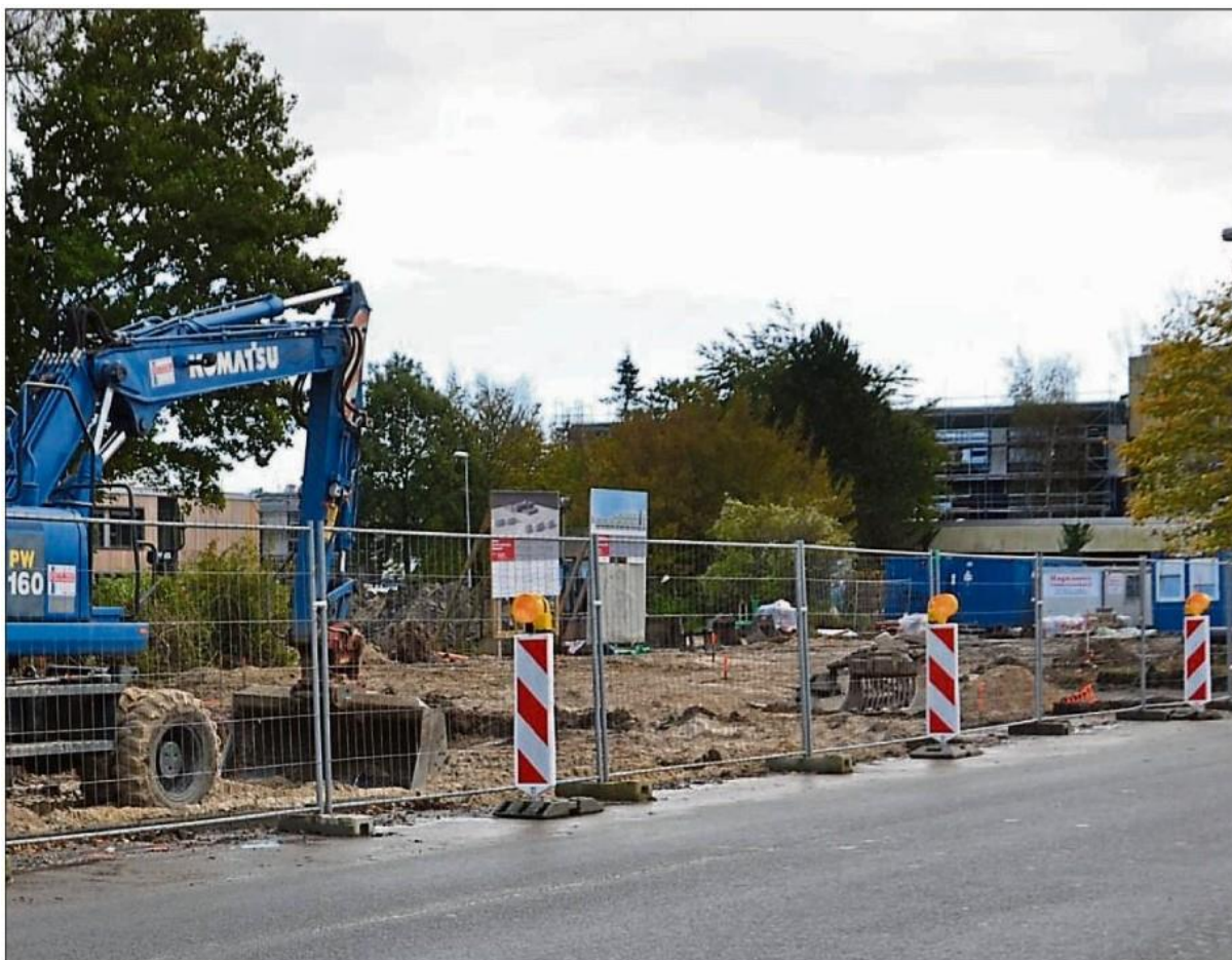
Im Zuge des Schulneubaus wird auch die Bushaltestelle erneuert. In Zukunft stehen die Busse schräg hintereinander. Die Anordnung wird Sägezahn-Prinzip genannt. Fotos: Habib
