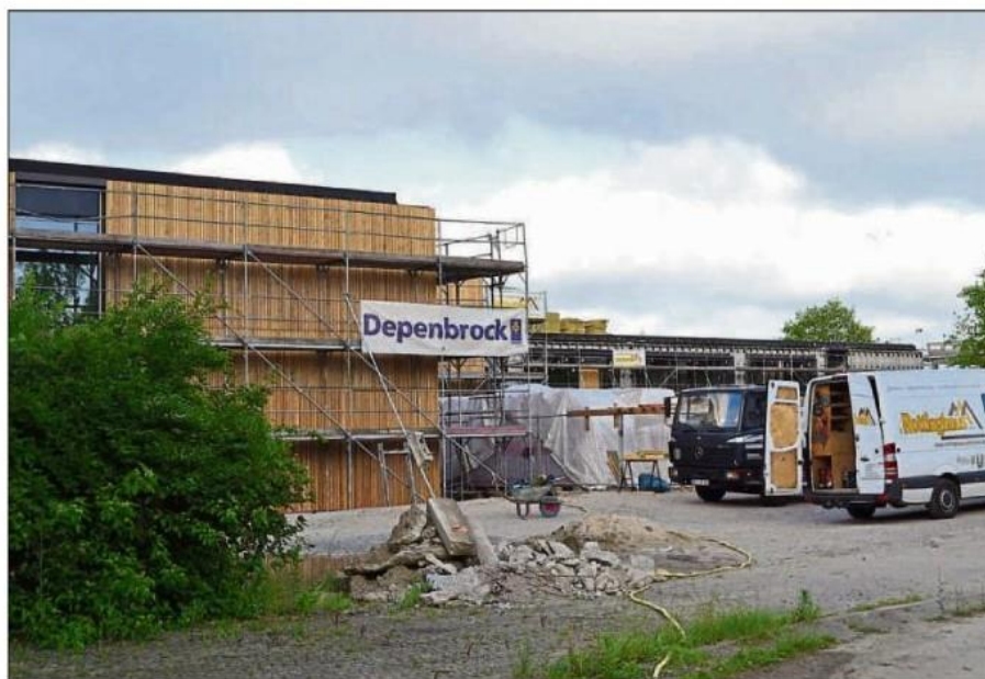
Seit einigen Tagen wird die Außenfassade der neuen Gemeinschaftsschule komplett mit Holz verschalt. Dass dafür sibirische Lärche verwendet wird, sorgte im Bauausschuss für Diskussion. Foto: Thaden
