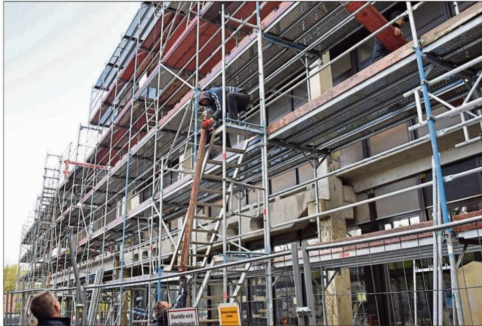
Ein Teil des Gymnasiums ist eingerüstet: Die Sanierung der Fassade soll 2019 abgeschlossen sein. Fotos: Reh
