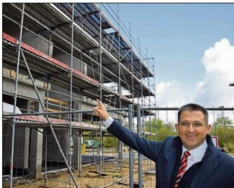
Der Fachtrakt-Anbau wächst zur großen Freude von Schulleiter Hans-Walter Thee in die Höhe. Foto: Reh
