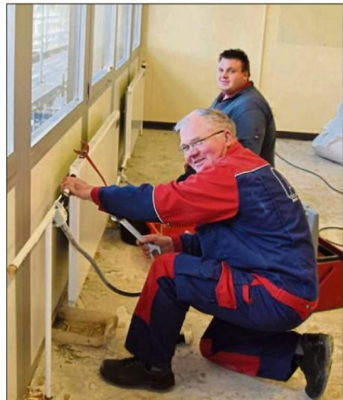
Bereiten die Fassadensanierung in den gesperrten Klassenräumen vor: Clemens Schmidt (vorne) und Felix Schlömp.
