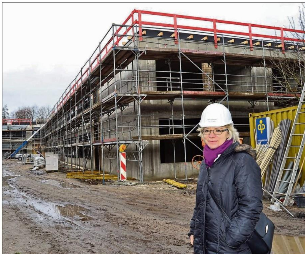
Bauamtsleiterin Astrid Gasse stattet der Baustelle regelmäßige Besuche ab. Rechts hinter ihr fehlen noch die Fenster. Auch sie sollen in diesen Tagen eingesetzt werden. Foto: Thaden
