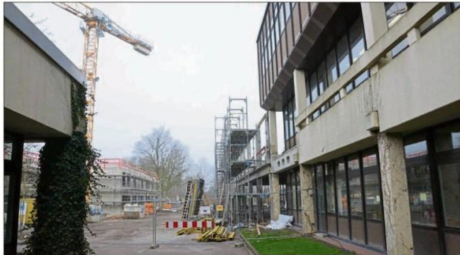
Drei Maßnahmen in unmittelbarer Nähe: Der Schulneubau (links) läuft, der Anbau des Fachtraktes ebenfalls (rechts). Nun beginnt auch noch die Fassadensanierung. Foto: Schmid
