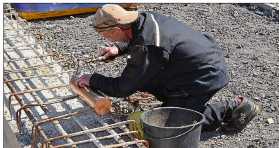
Verschleißt die Kupferrohre mit den Plänen: Ingo Sönnichsen von der Tischlerei Ole Peters.
