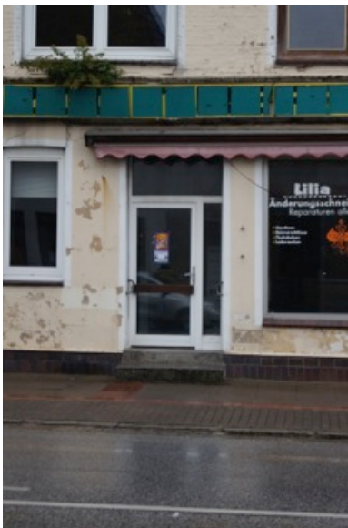
Hauseingang mit Geländer
